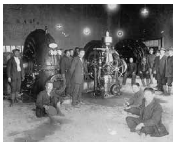
薬師発電所内部
