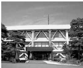
耐震補強工事が完成した 市役所本庁舎
