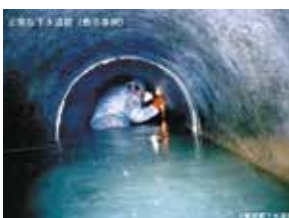
正常な下水道管（他市事例）
