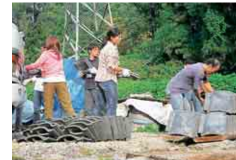
古民家修復作業 (北谷町小原)
