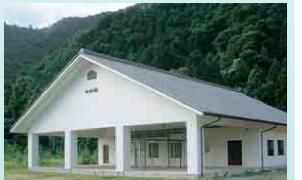
伊知地・坂東島地区農業集落排水処理施設
