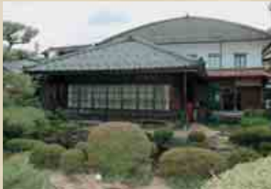
起り屋根の深谷家洋館(元診療所)
