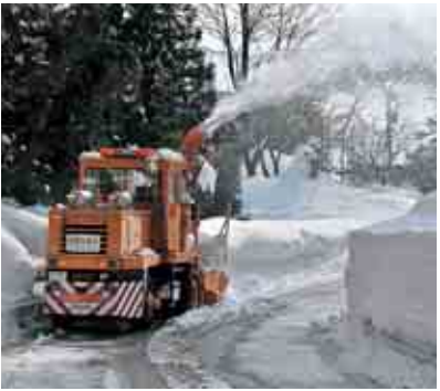
除雪作業の様子
