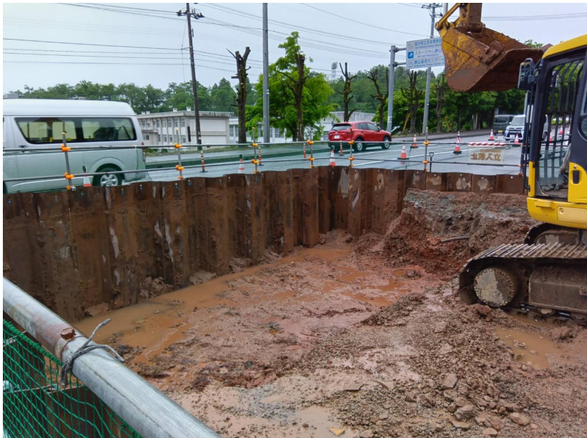
③開削土工
