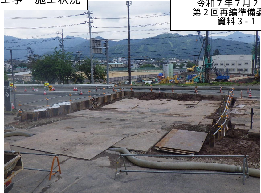
②仮設工（矢板圧入完了）
