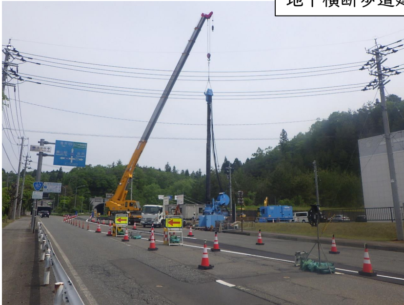
①仮設工（矢板圧入）
