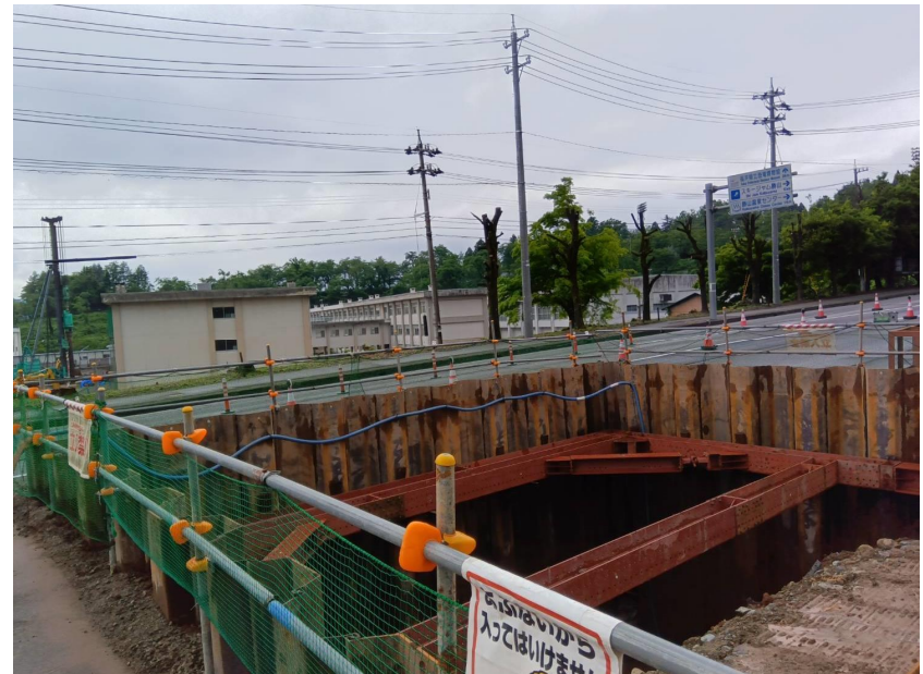
④仮設工（切梁・腹起し設置）
