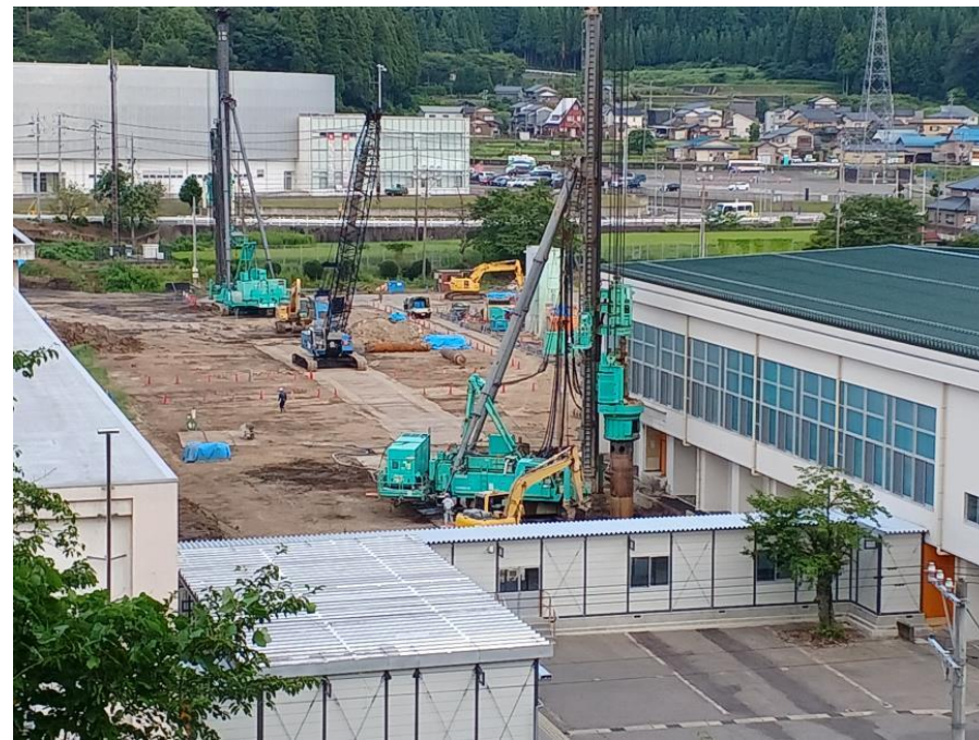
④杭工事（先行掘削）
