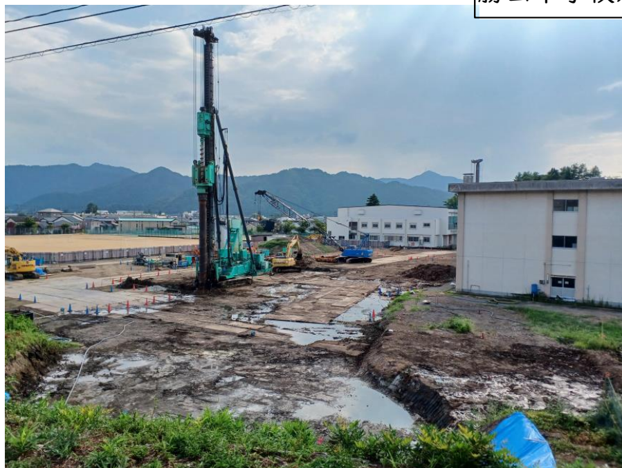
①杭工事（先行掘削）国道側から
