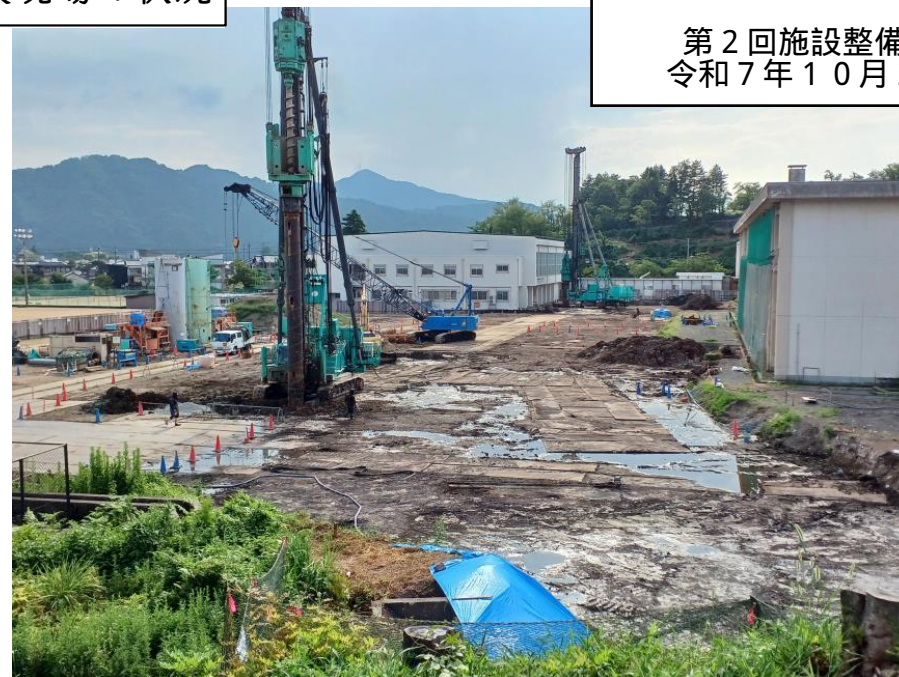
②杭工事（先行掘削）国道側から
