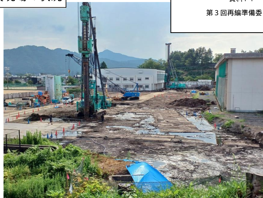
②杭工事（先行掘削）国道側から
