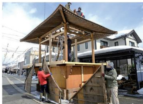
上郡区櫓の組み立て風景
