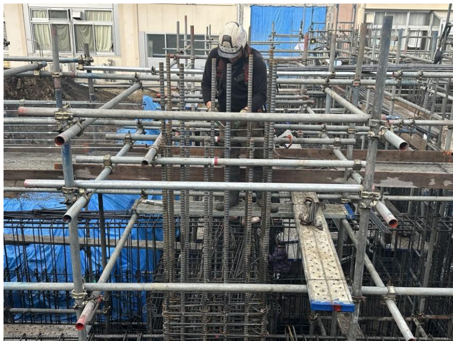
③基礎工事
