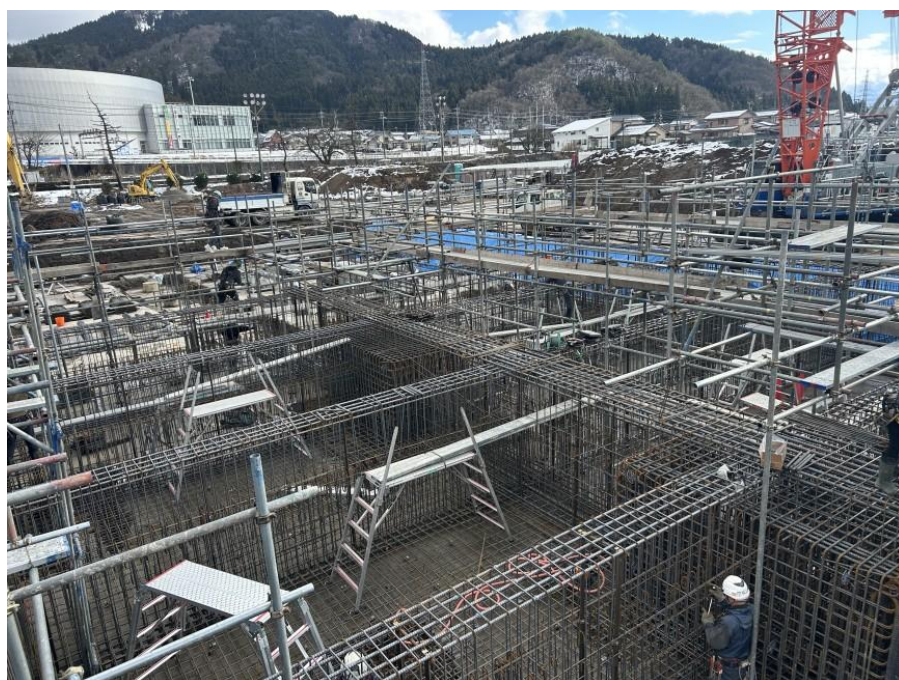
③基礎工事(配筋工事)
