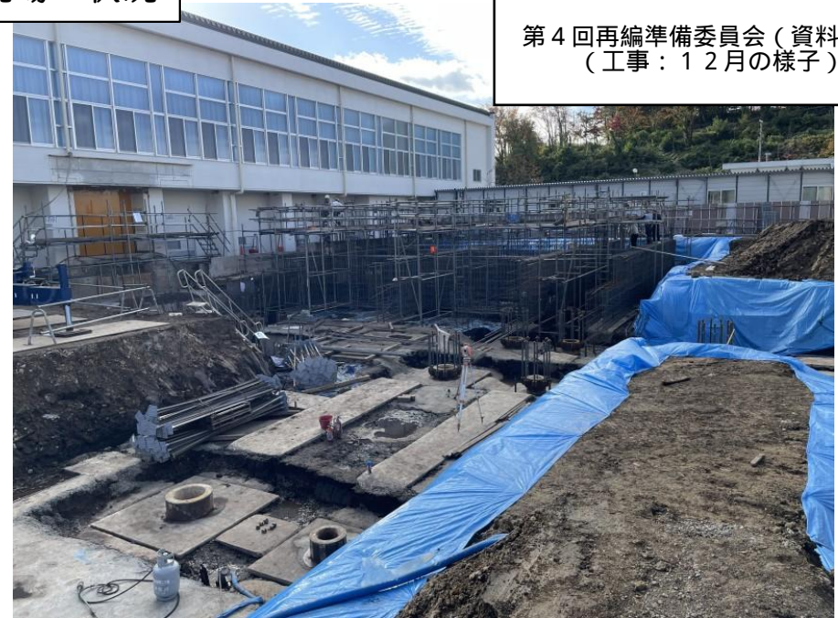
②基礎工事
