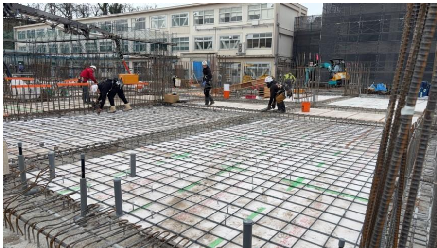
③1階躯体工事(床鉄筋工事)
