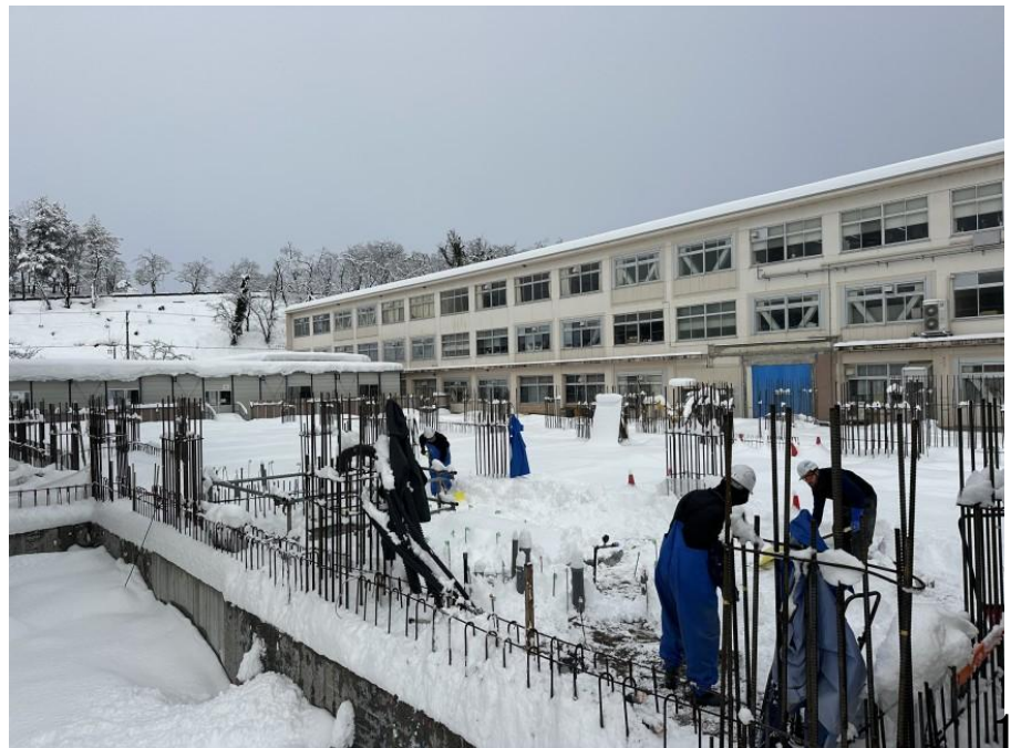
④基礎工事(配筋工事)
