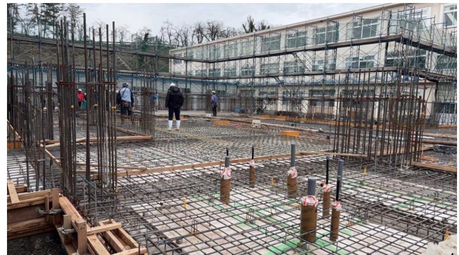
④1階躯体工事(床コンクリート工事)
