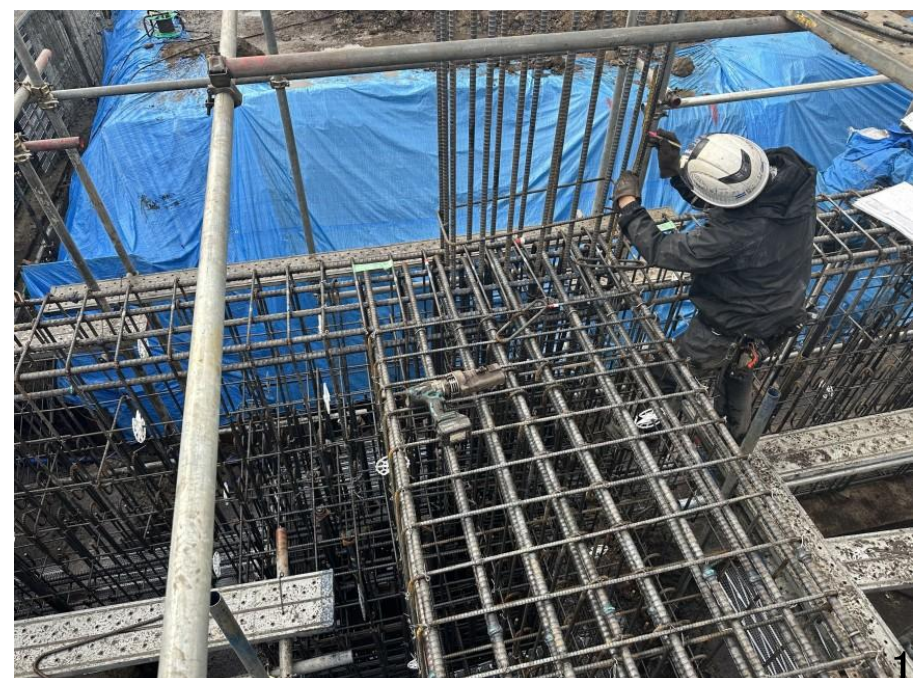
④基礎工事
