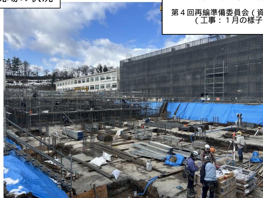
②基礎工事
