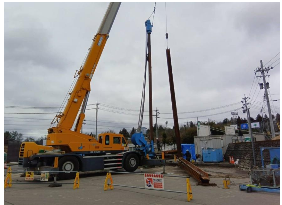
④仮設工(矢板圧入)
