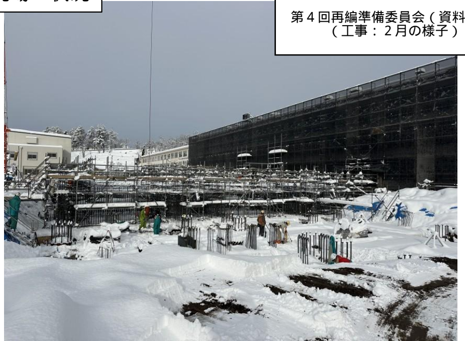
②基礎工事
