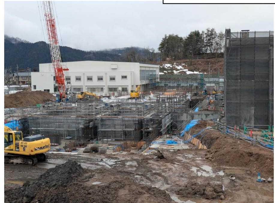
②基礎工事・1階躯体工事 国道側から
