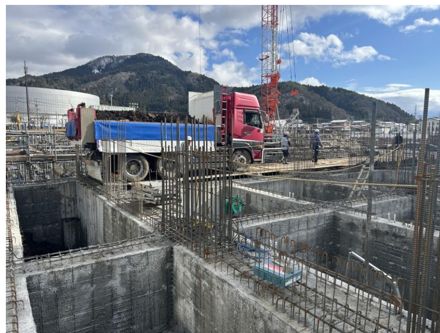
④基礎工事(コンクリート工事)
