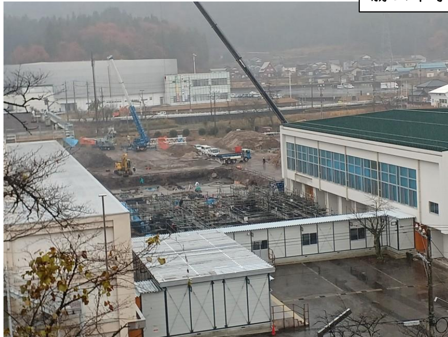
①基礎工事 長山公園側から
