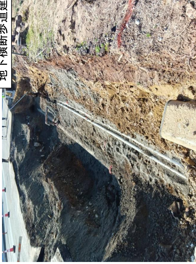
①地下埋設物事前確認
