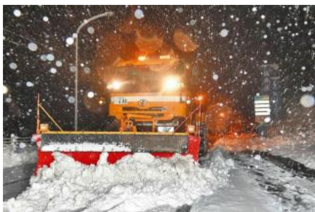
写真：北谷町谷の国道157号での除雪作業（2020.12）
