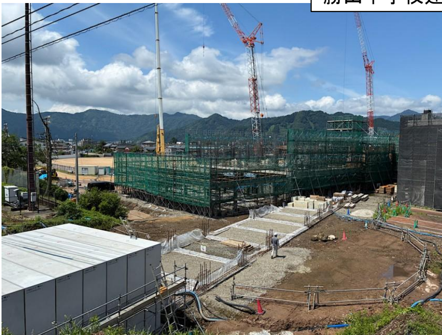
①平屋建ての給食室棟の鉄骨建方
