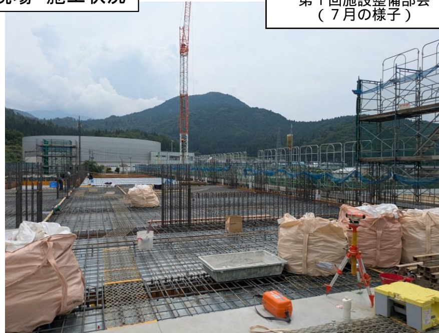
②校舎の鉄筋コンクリート工事
