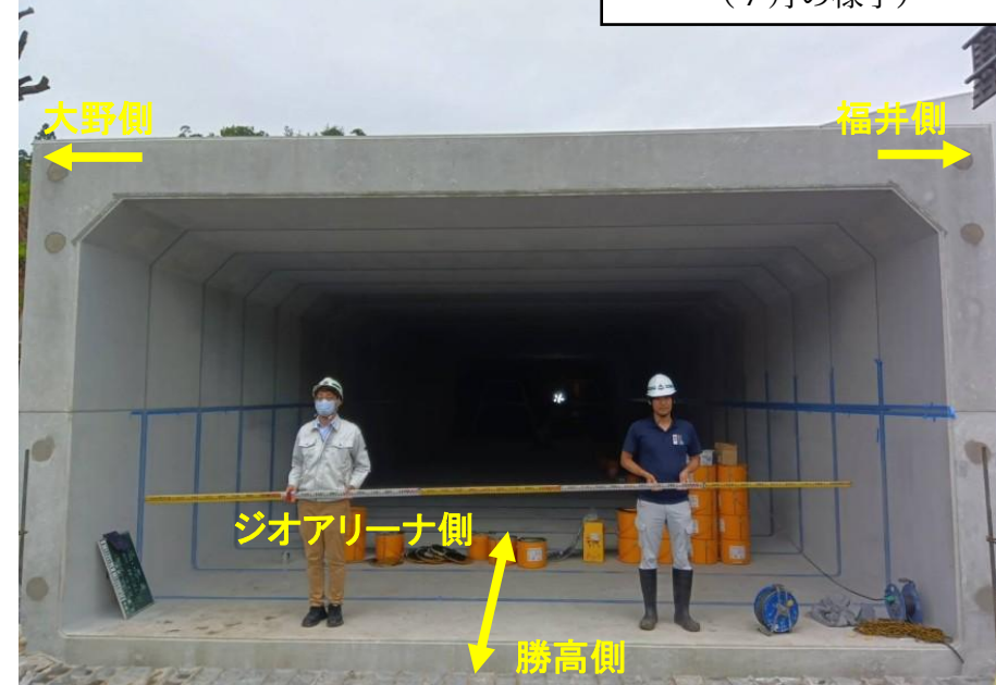
②ボックスカルバート据付(勝高側)
