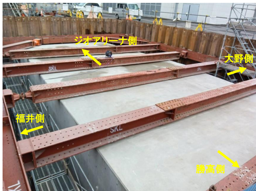
③本体コンクリート打設(ジオアリーナ側)
