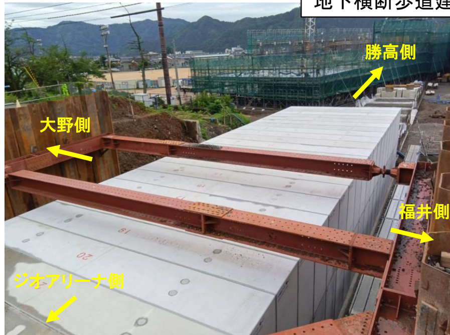
①ボックスカルバート据付(勝高側)
