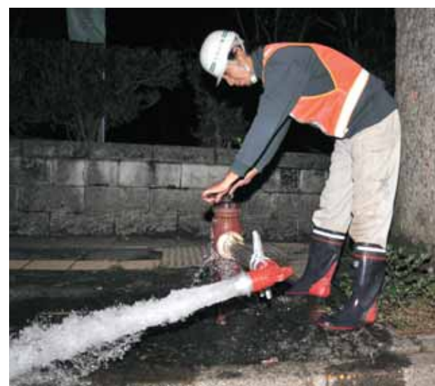
洗管作業の様子
