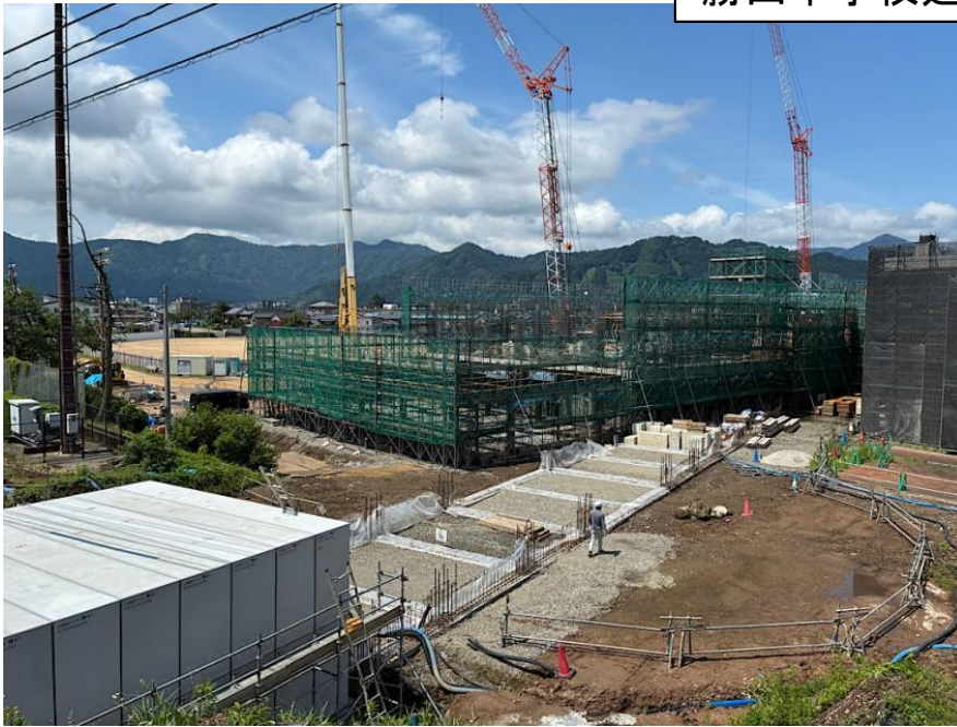
①平屋建ての給食室棟の鉄骨建方
