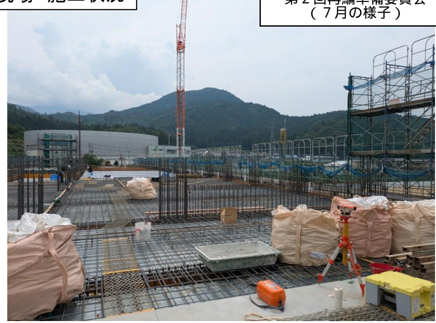
②校舎の鉄筋コンクリート工事
