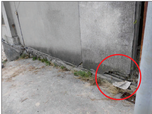
【ボード】 ボード隅角部に破損が生じている。
