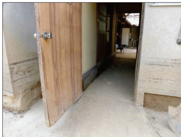
【ドア】 浸水によりドア等の面材が膨張し剥離している。 (再使用が不可能な程度)
