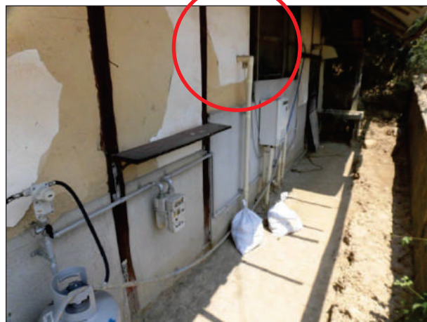
浸水により塗土の半分以上が剥落している。
