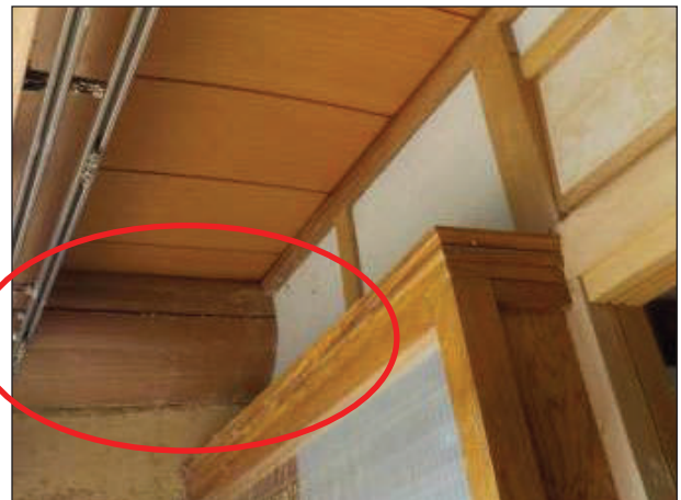
【在来工法】 柱、梁に割れが見られる。
