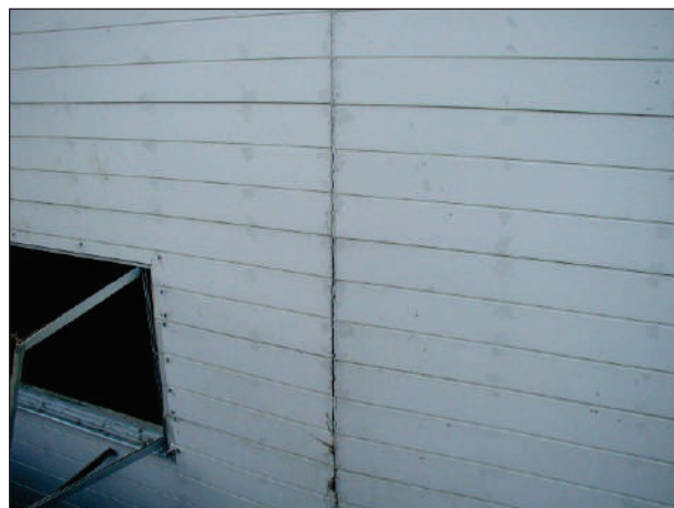
【ボード】 仕上面の目地部にひび割れやずれが生じている。
