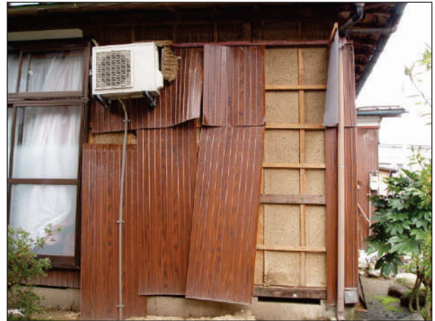
【ボード】 釘の浮き上がり、ボードの脱落が見られる。
