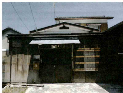
正面ポーチ 兼 作業場
