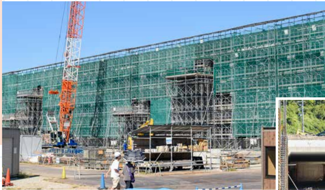
建設中の ←校舎
