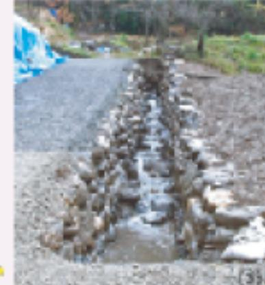
水路工事の前に発掘調査を進めていくと(写真①)、中世の水路が残っていることがわかりました(写真②)。そこでこの水路を修理し、現在の水路としても使うことにしました(写真③)。
