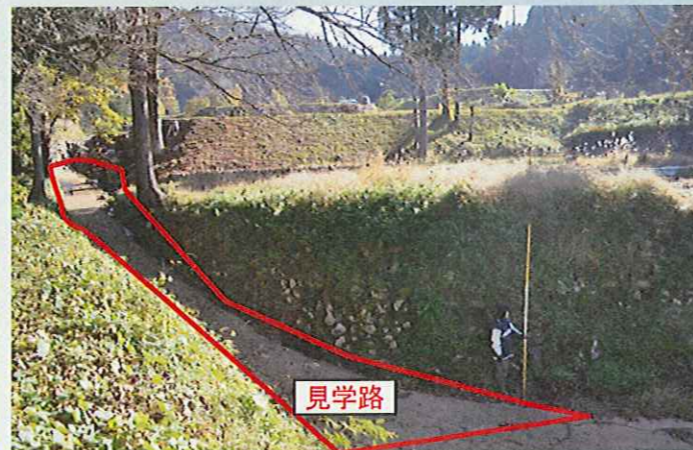
見学路の工事予定地
