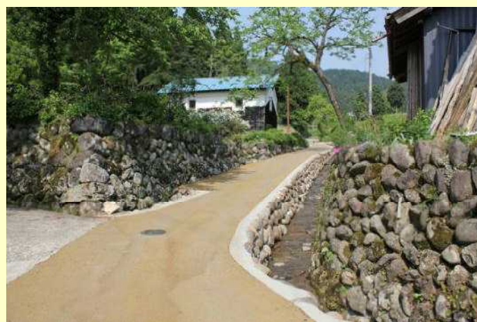
整備後 南大門跡付近
