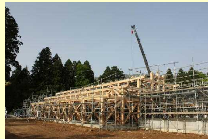
南西側から（トイレから事務所方向）
