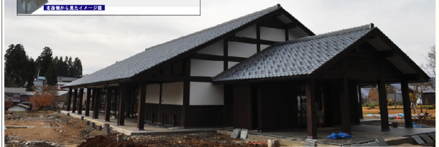
白山平泉寺歴史探遊館 まほろば (平成23年12月 建設中)
