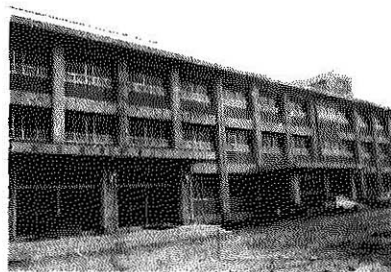
南部中学校校舎建設
