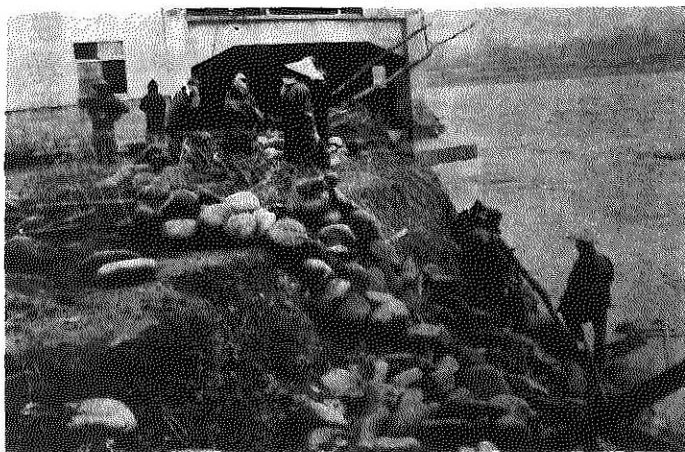
40. 9 風水害で大きな被害が出た遅羽町中島付近
