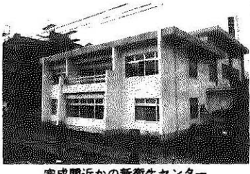
完成間近かの新衛生センター
