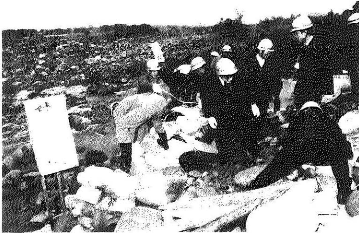
積み土俵工法を行う消防団員
