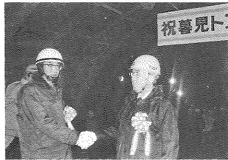
54年3月 暮見トンネル貫通
