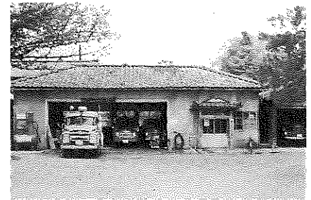
37年 建て替え前の旧消防署
