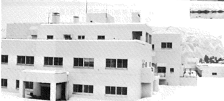
九頭竜川から浄化センターを望む
