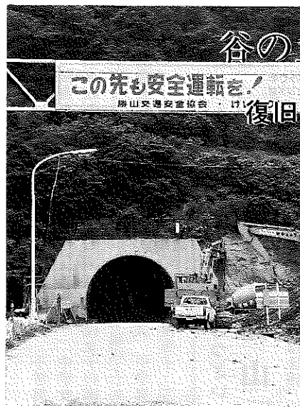
▲復旧工事がすすめられている 谷トンネル付近
