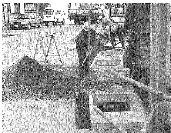
▲整備がすすむ流雪溝改良工事(元町3丁目付近)
