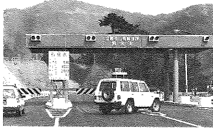
完成した 法恩寺山有料道路
