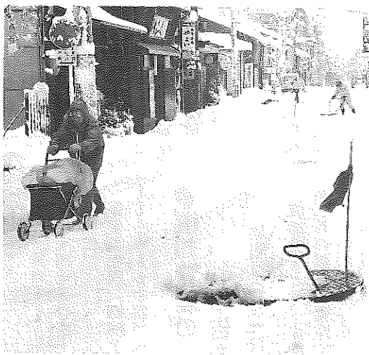
▲作業中は安全対策を
