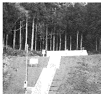
▶比島区に完成した水道施設(配水池)
