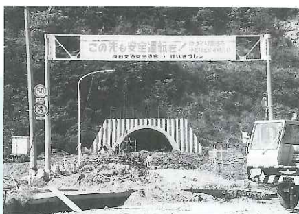
▲昭和61年5月 谷トンネル大規模土石流の復旧工事
