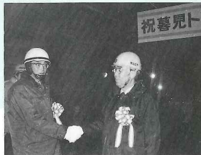
▲昭和54年3月 暮見トンネル貫通
