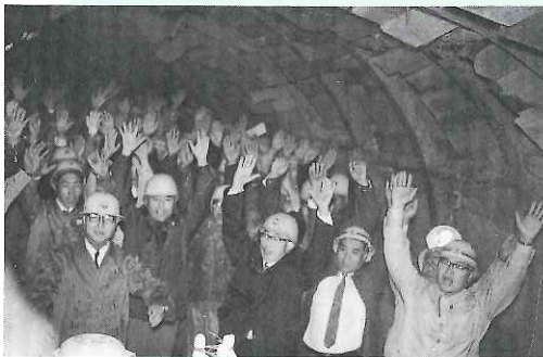
▲昭和45年5月 国道157号線新・谷トンネル貫通
