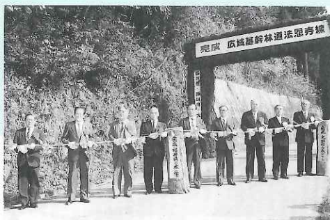
▲昭和63年 広域幹線林道「法恩寺線」全線開通
