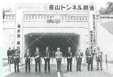
▲昭和59年6月 長山トンネル開通
