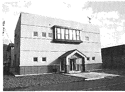
立川水源敷地内に建設された水道管理センター
