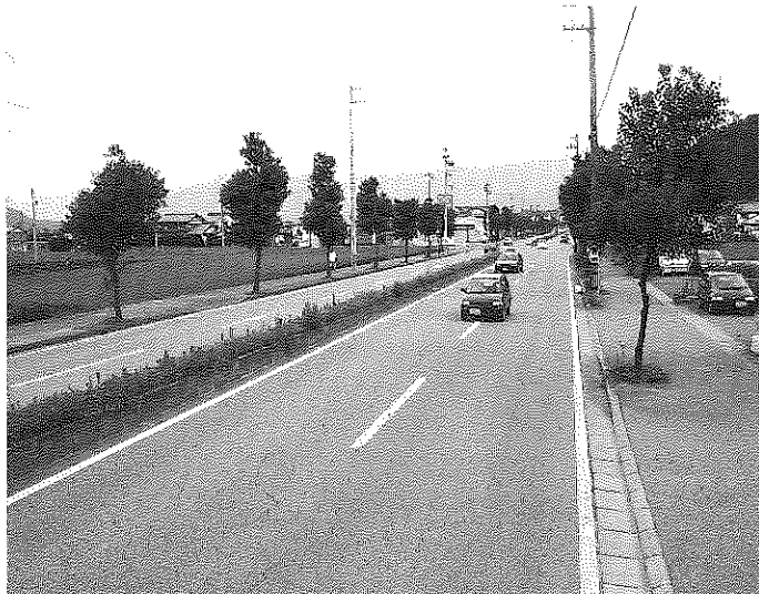
▲新しく準防火地域に指定された国道157号片瀬町付近
