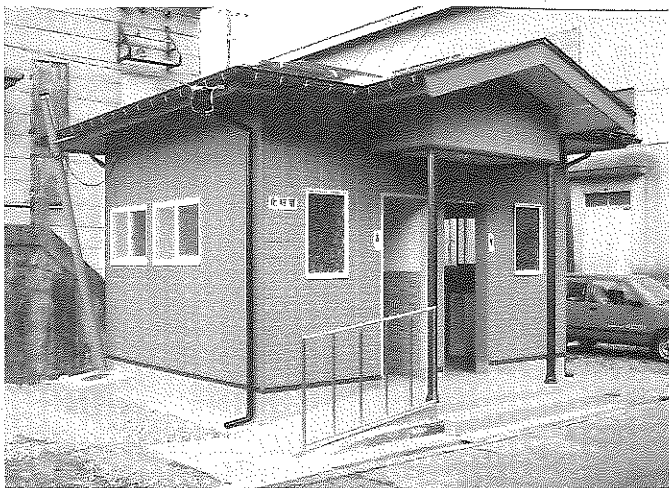
▶新しくなった駅前トイレ
