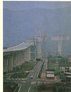
▲急ピッチで工事が進められている油坂峠道路
