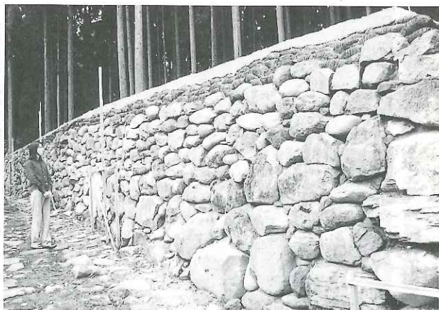
▶白山平泉寺旧境内ですすめられている石垣等の修復工事
