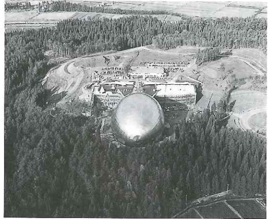
▲県立恐竜博物館の建設工事がすすむ 長尾山総合公園
