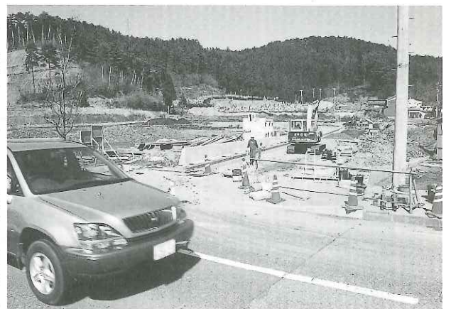
▶新火葬場に通じる開発道路の工事風景
