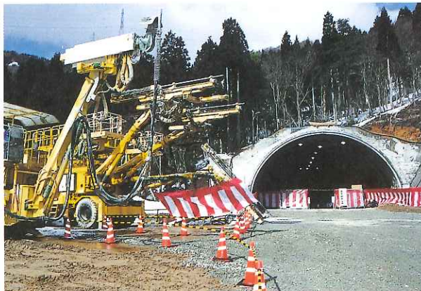
中部縦貫自動車道吉峰トンネル工事が着工（2月）
