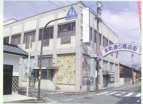
勝山市民活動センターの設置が決まった福井銀行勝山支店跡
