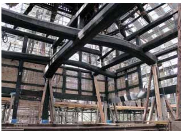
修理途中の建物内部
