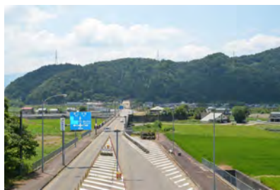
国道 157 号の未改良区間
