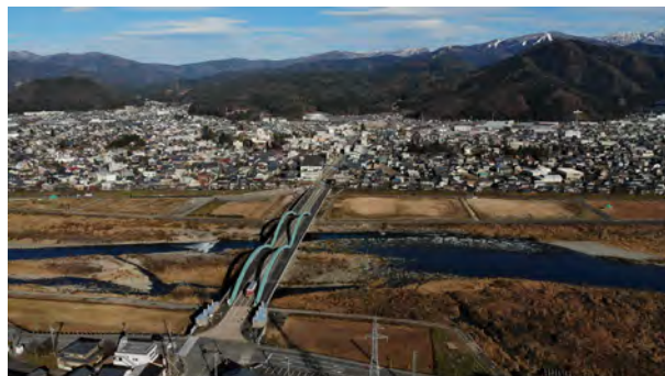
勝山橋から市街地方面への空撮
