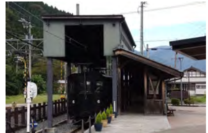
電気機関車テキ6 展示施設
