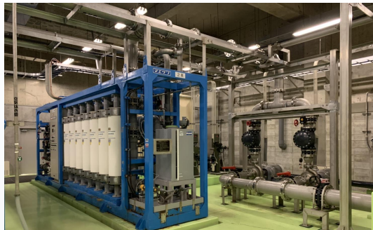
法恩寺 膜ろ過施設
