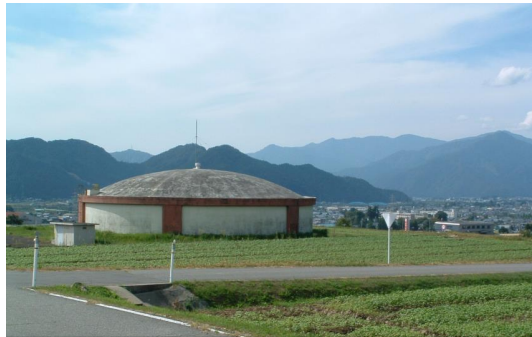
平泉寺配水池
