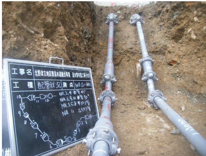
送水管 ダクトイル鋳鉄管 耐震管
