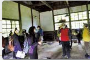
旧神谷発電所内部
