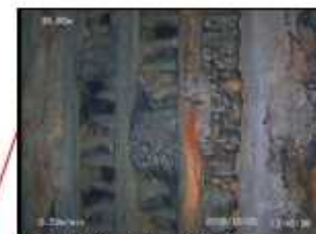
① スクリーン部 巻線破損
